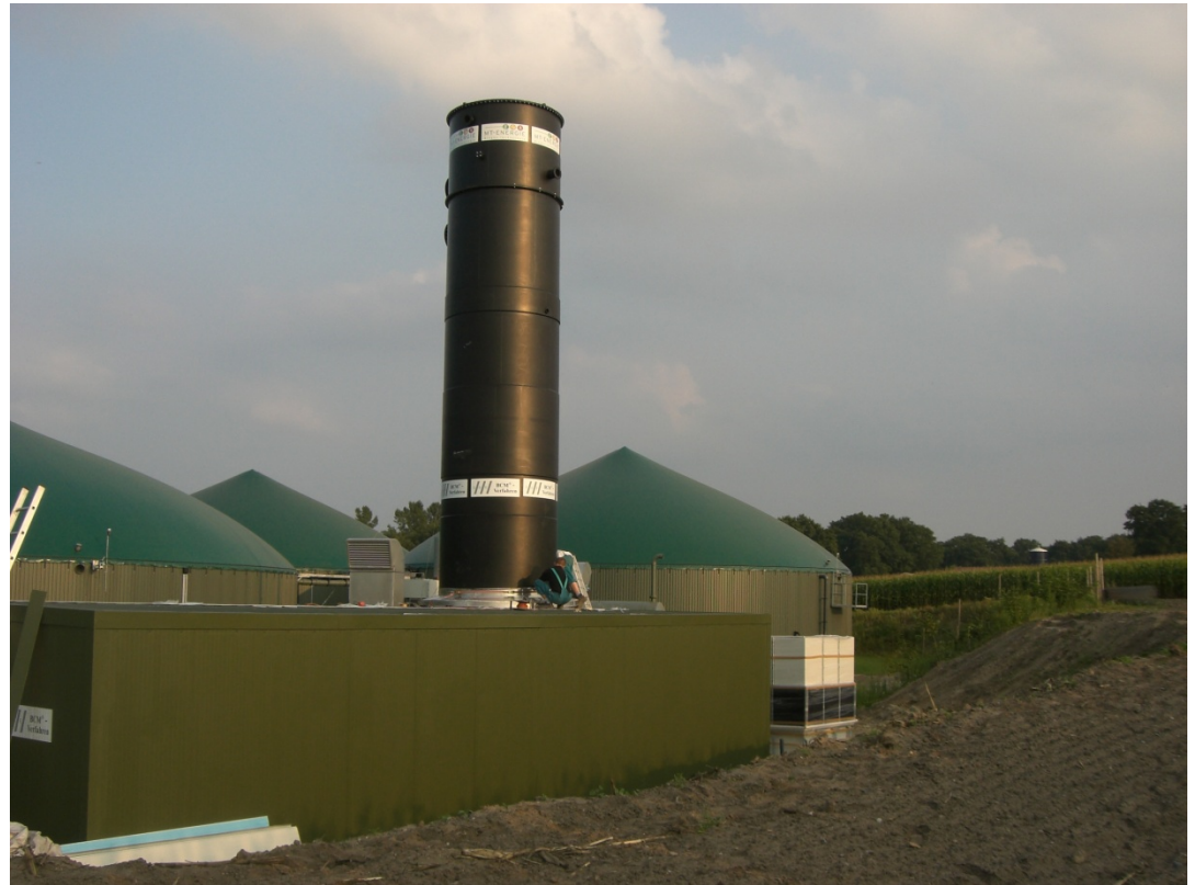
Großanlage 600 Nm 3 /h
